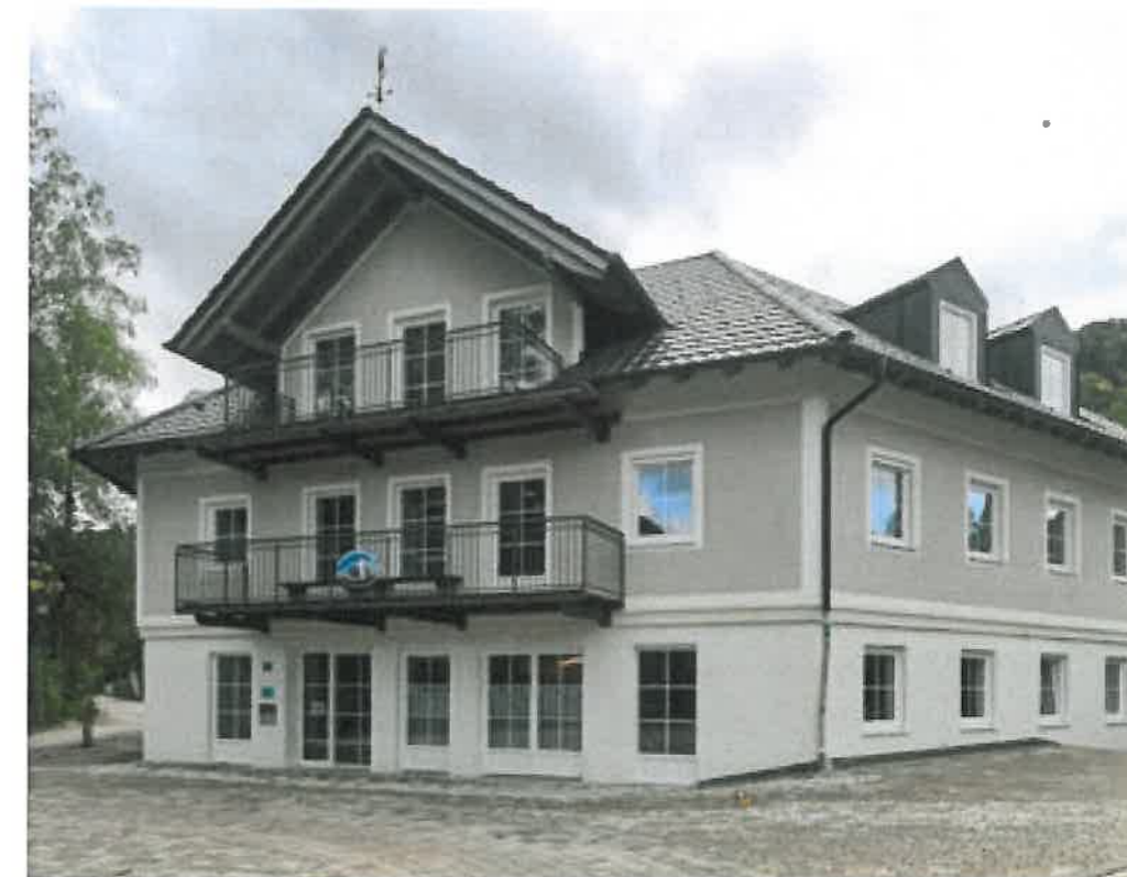
Zwölf behindertengerechte Appartements und drei Wohnungen für Pflegepersonal beherbergt das „Nest“ in Aschau im Chiemgau. Fotos: Josefine Unterhauser
